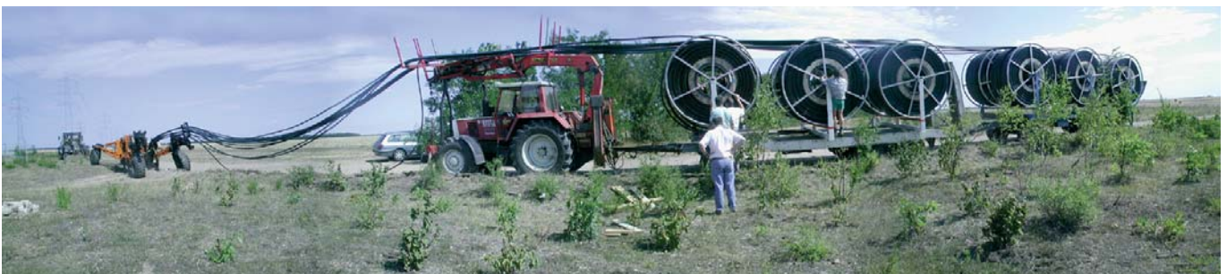
Ábra: 12 LWL-cső egyidejű lefektetése behúzással (PAC-ABLE-rendszer).
